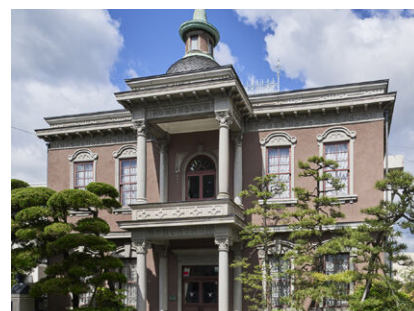
城西浪漫館(中島病院旧本館)
